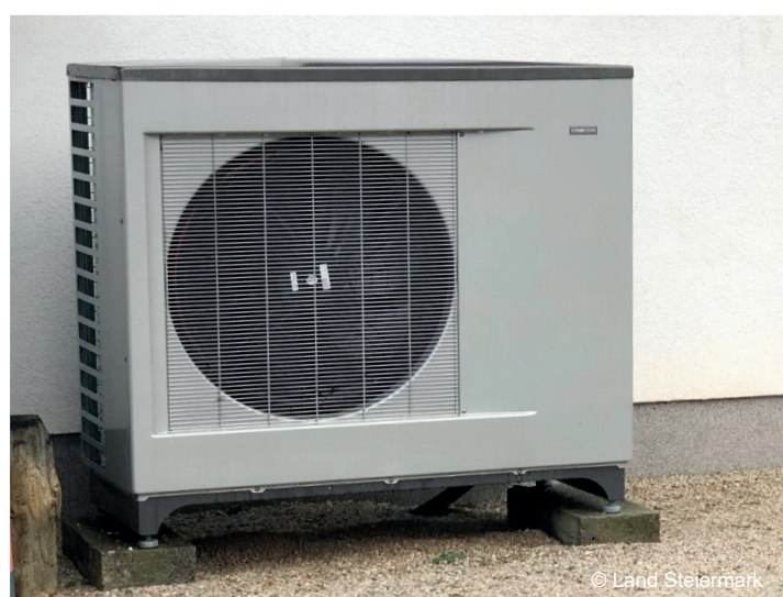
Abbildung: Wärmepumpe im Freibereich
