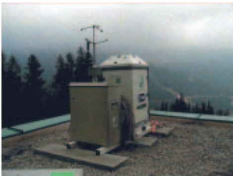
2D-Video-Distrometer am Dach der Bergstation des Grübl-Lifts (Präbichl)
