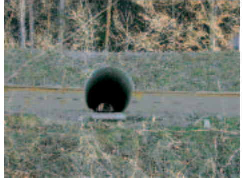
Spiralrohr, \varnothing 1000 mm, mit Holzleitwand, Lauffläche Holz
