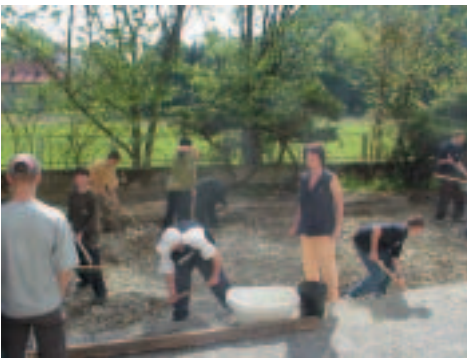
Aushub der Tiefenzonen
