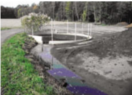
*Mangelhafte Entsorgung der Sickerwässer (Wartung der Sickerwassersammeleinrichtungen)*
