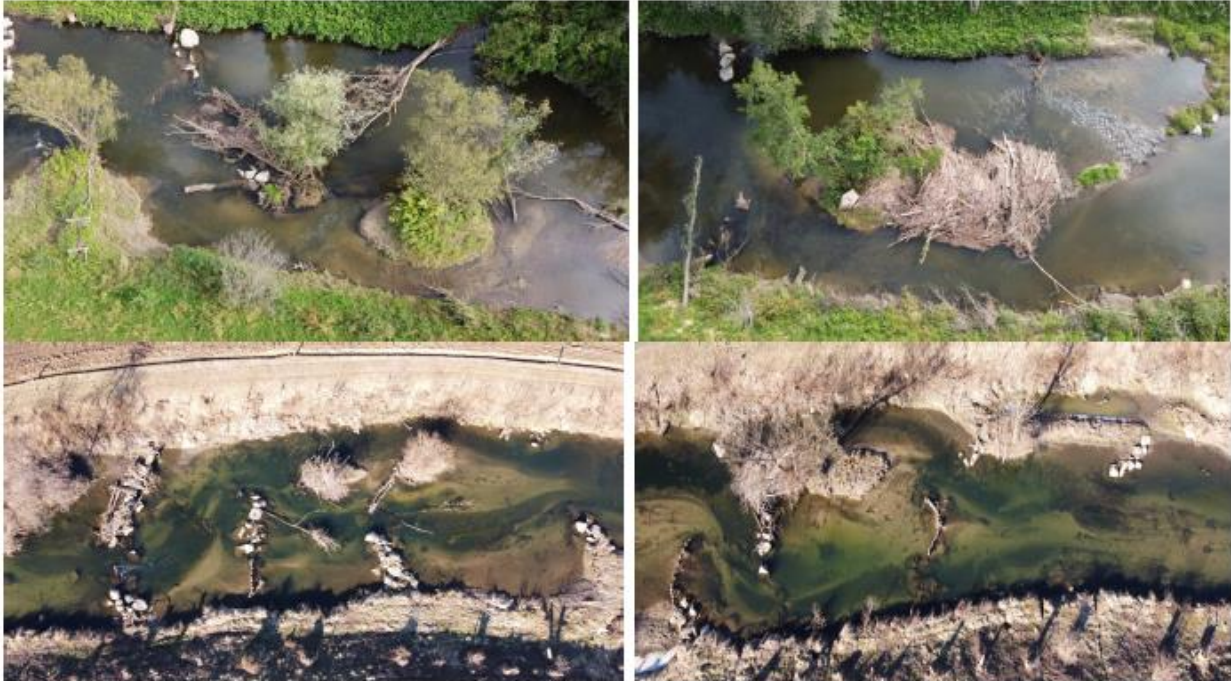
Abbildung 2: Beispielstrecke für den aufgeweiteten und sohlstrukturierten Abschnitt der Sulm flussab Gleinstätten (Quelle: G. Parthl).
