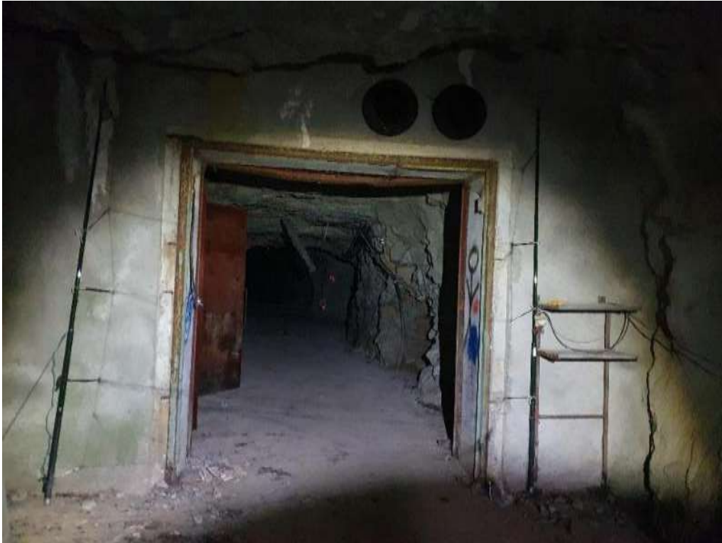
Abbildung 5-4: Fangstandort Stolleneingänge IV und V der Hammerbachursprung-Stollenanlage.
