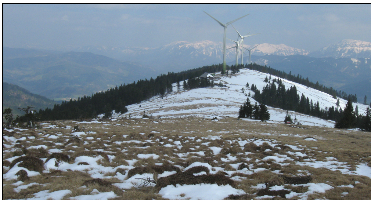
Abbildung 4: Blick von der Grenze des Landschaftsschutzgebietes Nr. 22 zum Windpark Moschkogel. Auf dem freien Höhenrücken im Bildmittelgrund ist in Verlängerung der bestehenden Anlagenreihe die Errichtung von zwei weiteren Windkraftanlagen geplant. Der Standort war immer schon, auch vor Errichtung des Windparks, von geringer Bedeutung für das Birkhuhn.
