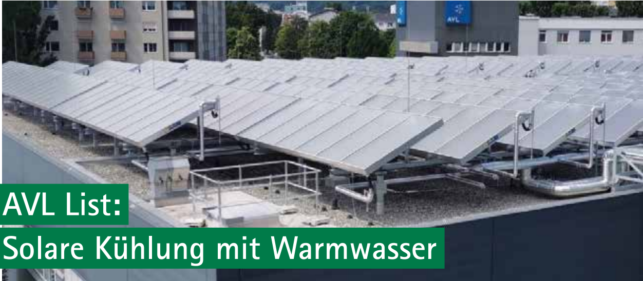
Abb. 38: Solarthermische Anlage am Dach eines Bürogebäudes der AVL
