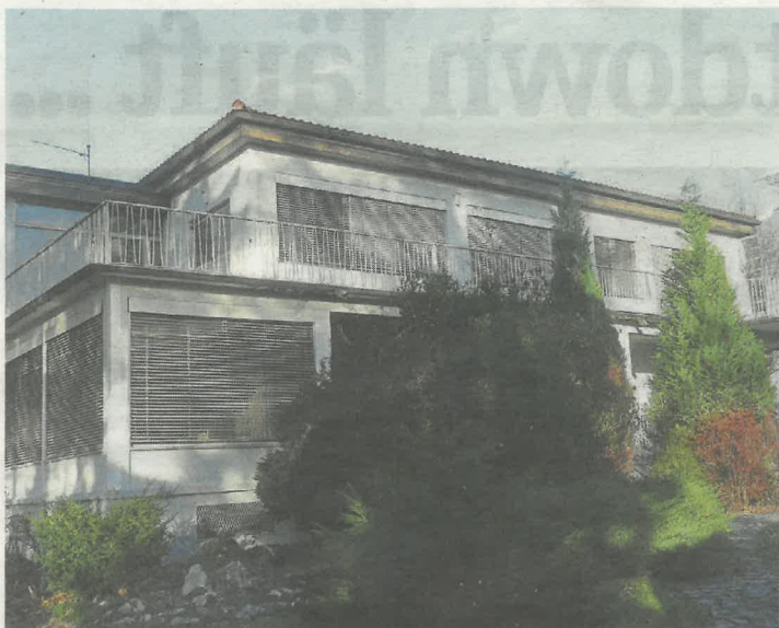
Das Haus Albrecher-Leskoschek in der Hilmteichstraße wurde 1937 vom bedeutenden Grazer Architekten Herbert Eichholzer errichtet.
