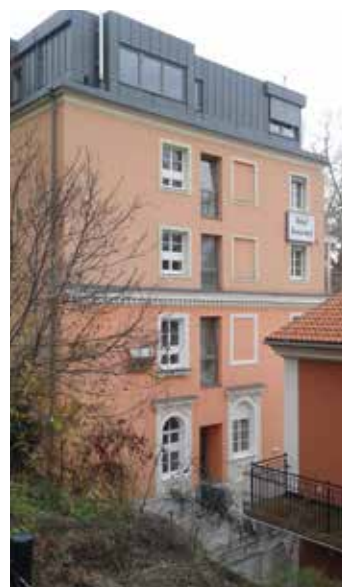
Hotel Grazerhof Aufstockung
