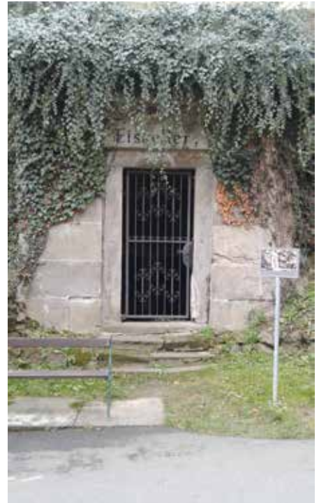
Bad Gleichenberg, ice cellar Brunnenstraße (c) G. Kanhäuser
