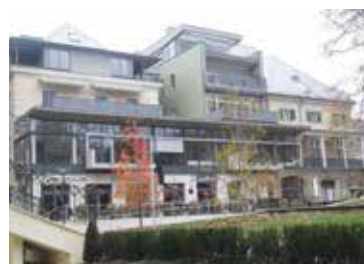
Bad Gleichenberg, Hauptplatz - neue Verdichtung
