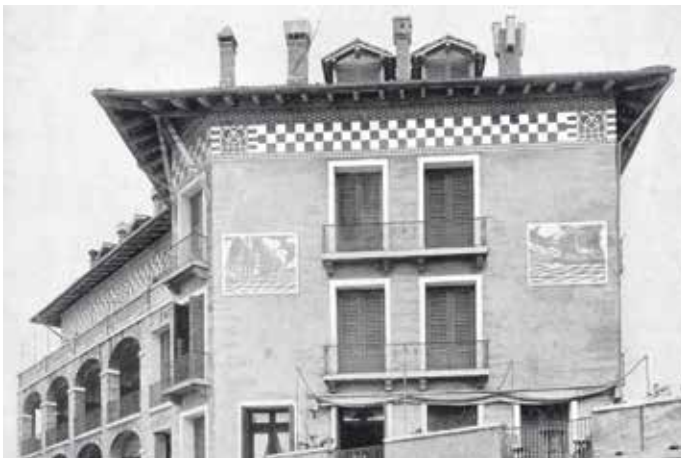
La Pensione «Fortino» in due immagini pubblicate sulla rivista "Der Architekt", 1903.
