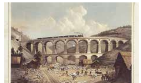
Semmering viaduct (Semmeringbahn), 1854
