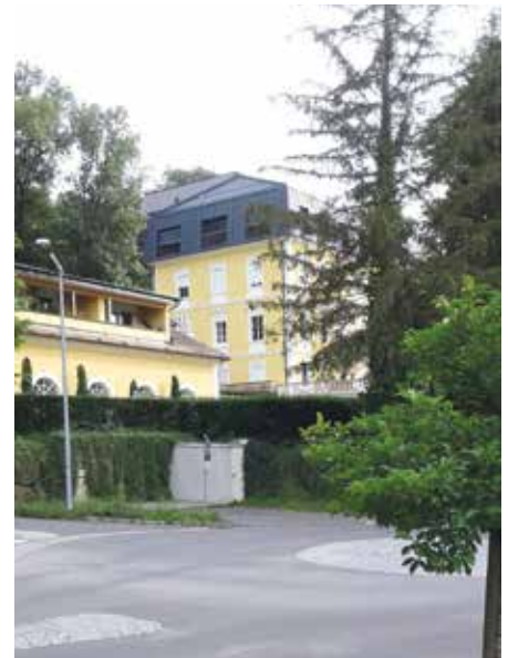
Villa Gleichenberg, roof floor (c) G. Kanhäuser
