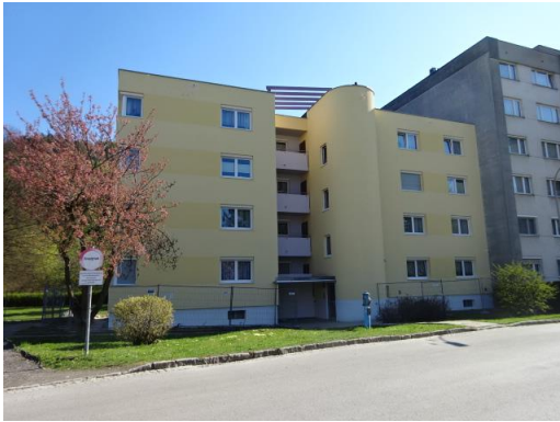
Foto Wohnhaus Nordansicht
